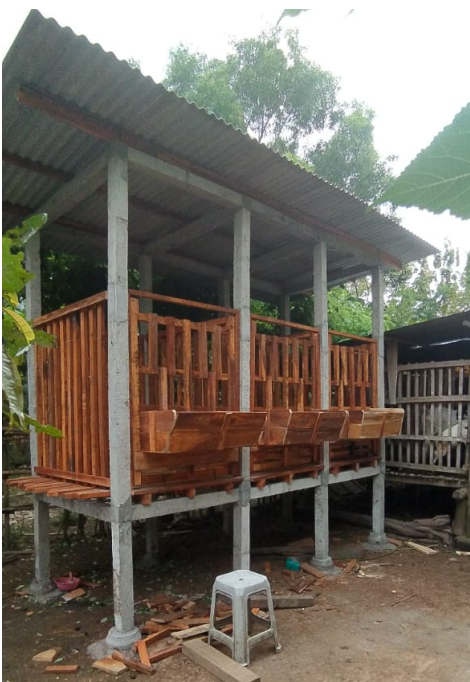
Gambar 13 Hasil akhir pembuatan kandang kambing dengan struktur sederhana beton pra-cetak
