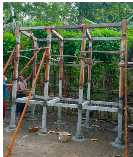
Gambar 10 Perakitan kolom dan balok kandang kambing
