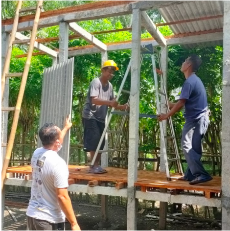
Gambar 11 Pemasangan lantai dan atap kandang kambing
