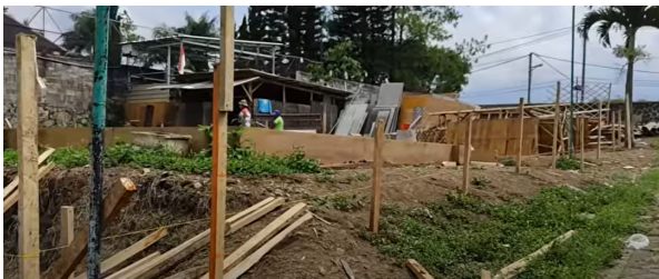
Gambar 5 Kondisi eksisting lokasi bangunan
