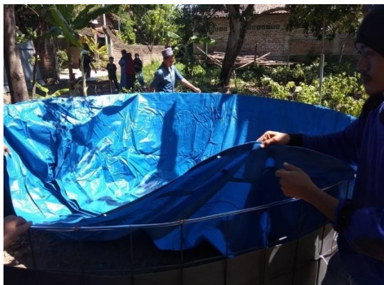
Gambar 9. Proses pemasangan terpal
