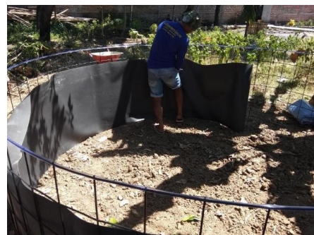
Gambar 6. Pemasangan terpal talang
