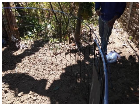
Gambar 5. Pemasangan pelindung wiremesh
