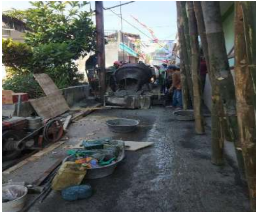
Gambar 8. Pekerjaan pengecoran plat dan balok
