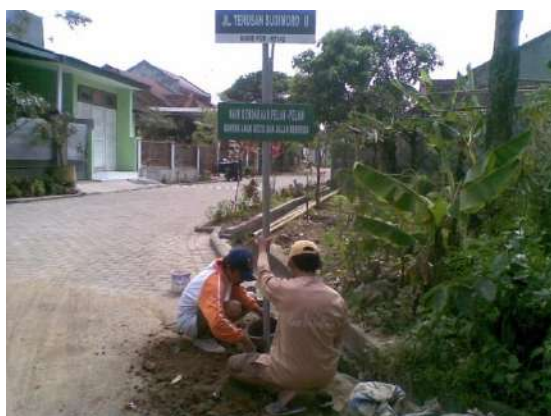
Gambar 4 Pemasangan petunjuk jalan
