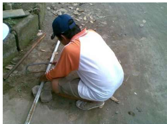
Gambar 3 Pematangan pipa untuk tiang
