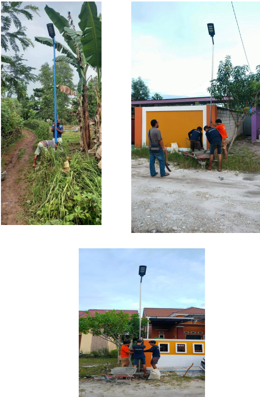
Gambar 5 Dokumentasi kegiatan pemasangan Lampu jalan oleh tim PKM Polinema
