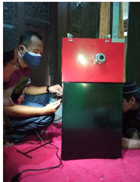
Gambar 9 Proses instalasi kelistrikan
