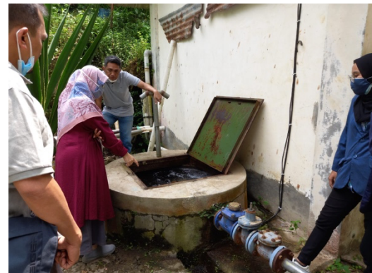
Gambar 1 Pengecekan air sumber sebagai bahan baku utama
