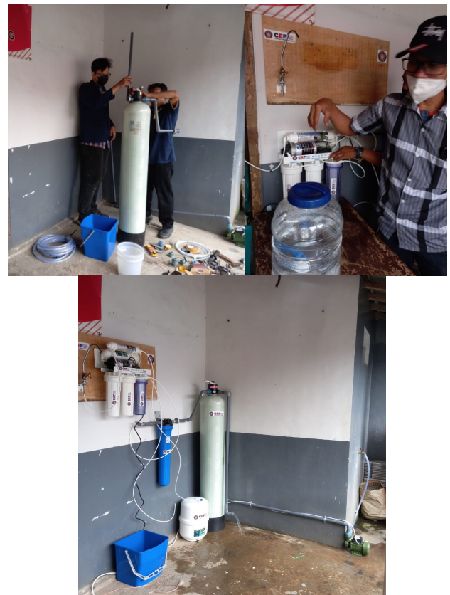
Gambar 3 Proses instalasi alat reverse osmosis untuk pengolahan air sumber menjadi air minum
