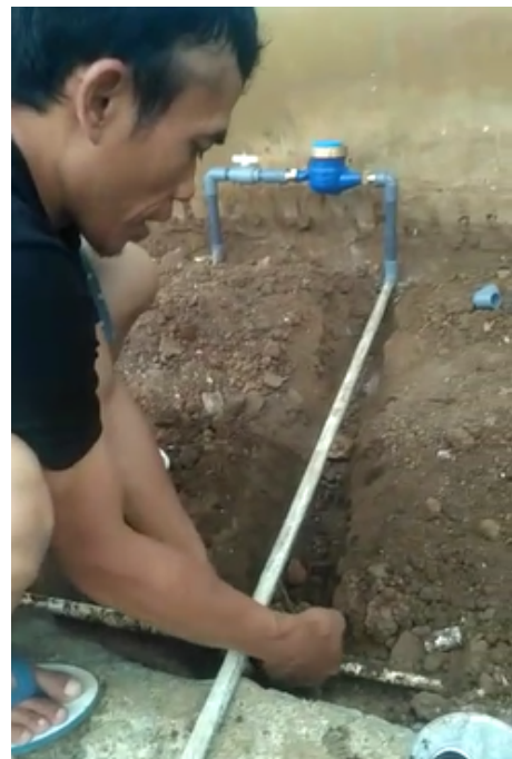
Gambar 7 Pemasangan pipa dari meteran
