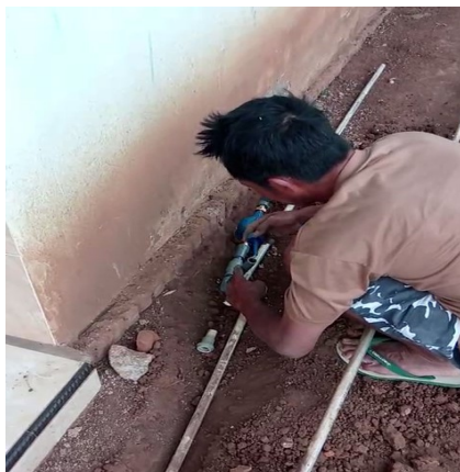
Gambar 6 Pemasangan meteran air.
