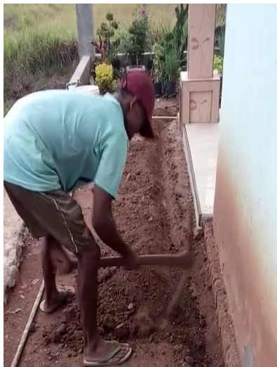
Gambar 5 Membuat parit untuk memasang pipa
