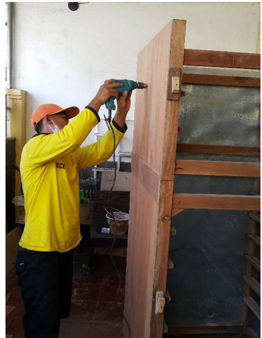
Gambar 4 Pemasangan dinding luar
