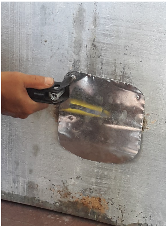
Gambar 10 Penutupan lubang bekas fan
