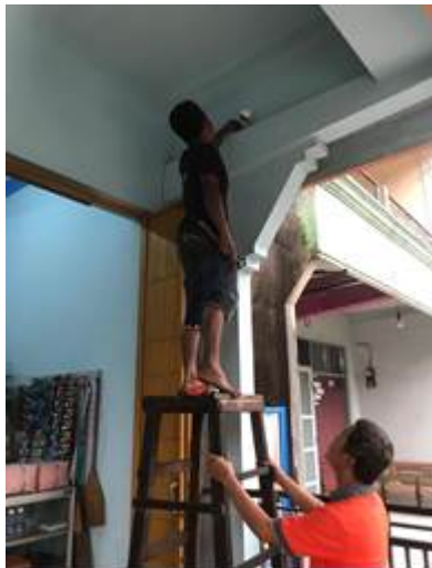
Gambar 5. Pemasangan IP Camera CCTV pada salah satu rumah mitra
