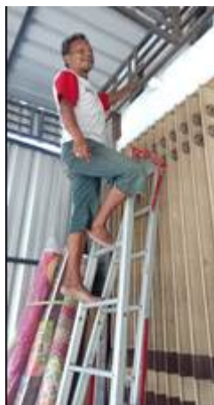
Gambar 6. Survei Lokasi Pemasangan IP Camera CCTV
