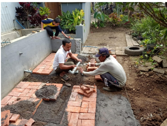
Gambar 2 Pemasangan dasar kolam dan sistem pembuangan air
