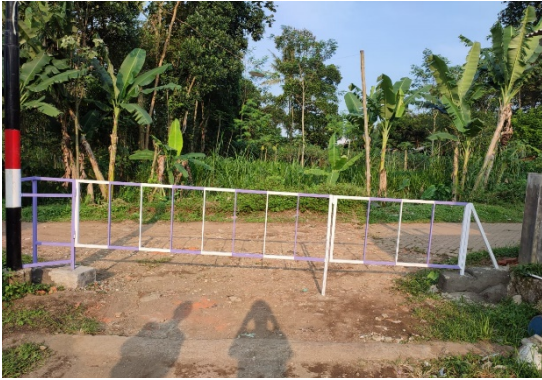
Gambar 10 Portal terpasang pada ujung depan jalan
