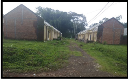
Gambar 1 Kondisi pemukiman warga RT/RW 05/10 Desa Kedungrejo
