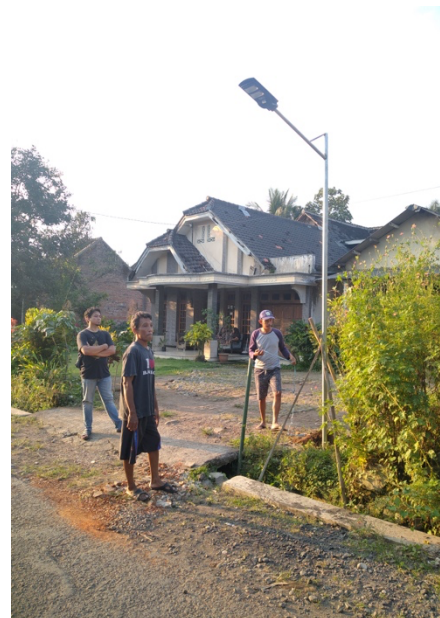
Gambar 6. Lampu Smart PJU panel surya terpasang di lokasi kegiatan
